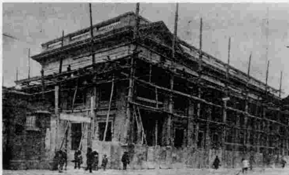
Facultad de Medicina en construcción.
